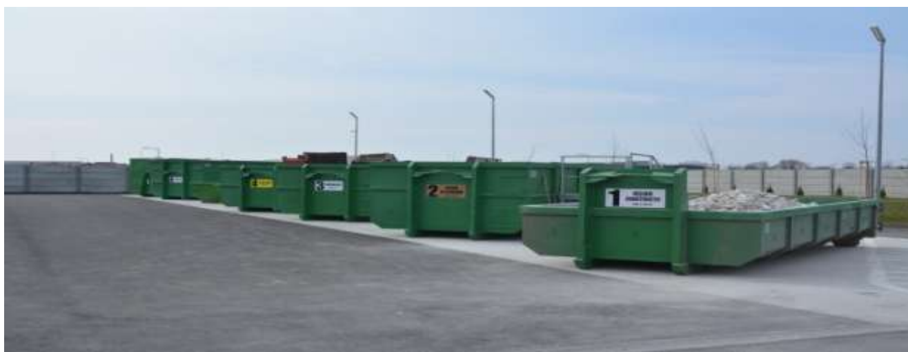
Figura VII.1.1.1 Platforma pentru colectare prin "aducere", amenajată și administrată de RER Vest SA Oradea
