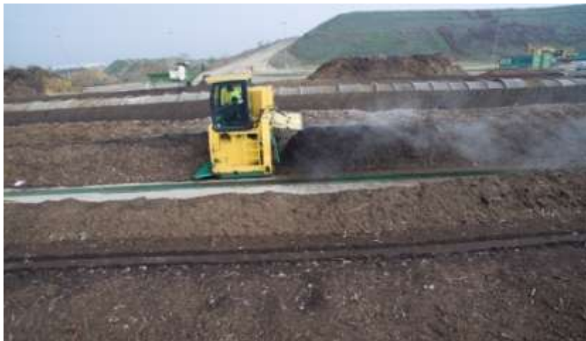
Figura VII.1.1.5 Platforma/stația de compostare a Eco Bihor SRL din Oradea
